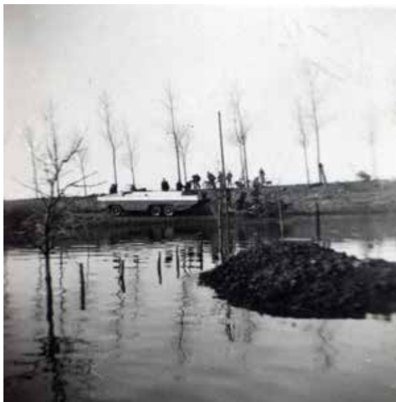
Foto 5. Una squadra al lavoro su una diga (Foto Archivio del Comando di Torino)
