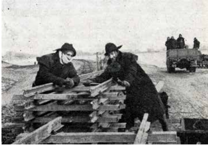
Foto 12. Sistemazione delle rotaie decauville (Foto Rivista "Antincendio")
