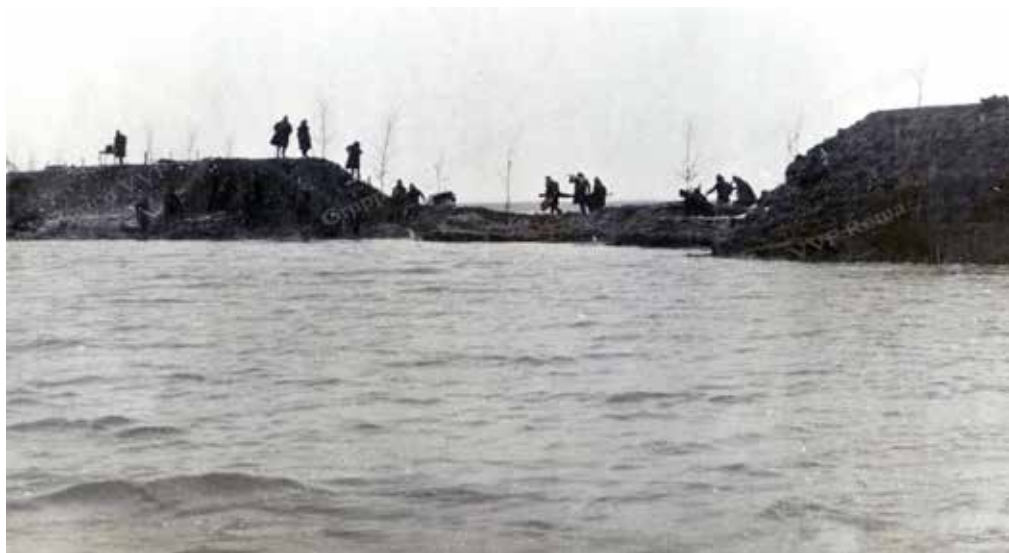
Foto 4. Vigili del Fuoco intenti alla riparazione di una breccia nella diga loro assegnata (Foto Gruppo Storico VVF Roma)
